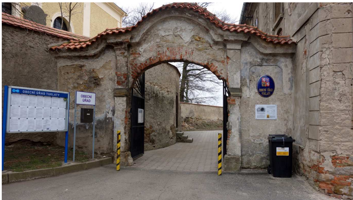
STÁVAJÍCÍ STAV – čelní-lícní uliční část
